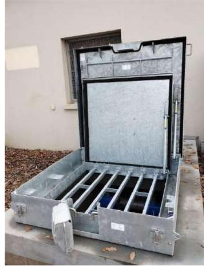
*Forage de Boigny - installation d'une trappe haute sécurité*
